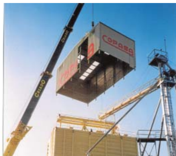
Colocando la nueva torre de fabricación. Año 2002.
