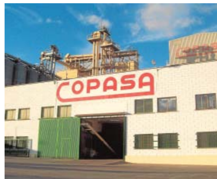
Exterior de las instalaciones de COPASA.
